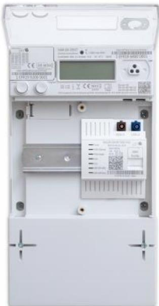
*Bild: EFR-Zähler SGM-DD mit LMN-Adapter und Secure Smart Grid Hub*
