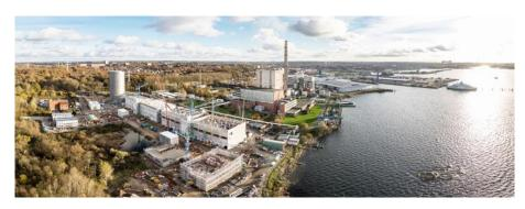
Der Wärmespeicher und der Elektrodenkessel des Küstenkraftwerks Kiel stehen schon, die Hallen für die 20 KWK-Motoren sind fast fertig.
