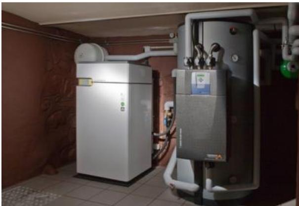
*Sparsam, komfortabel und hygienisch: Das Prinzip der von Geothermia geplanten Vorführanlage – sie besteht aus einer Wärmepumpe, Wärmespeicher und einem Frischwassererwärmer – eignet sich für Ein- und Mehrfamilienhäuser, denn die Leistung lässt sich je nach Anforderungen skalieren.*
