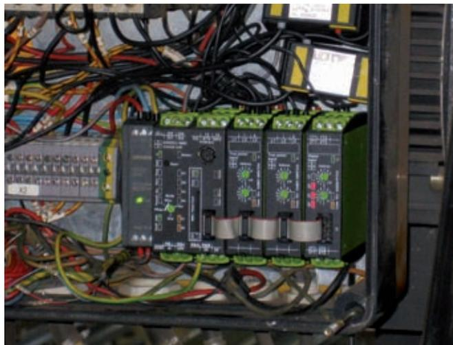
Kein Problem beim Einbau: Die kompakten WatchDog-pro-Module benötigen nur wenig Platz im Schaltkasten und bringen trotzdem umfangreiche Speichermöglichkeiten mit.
