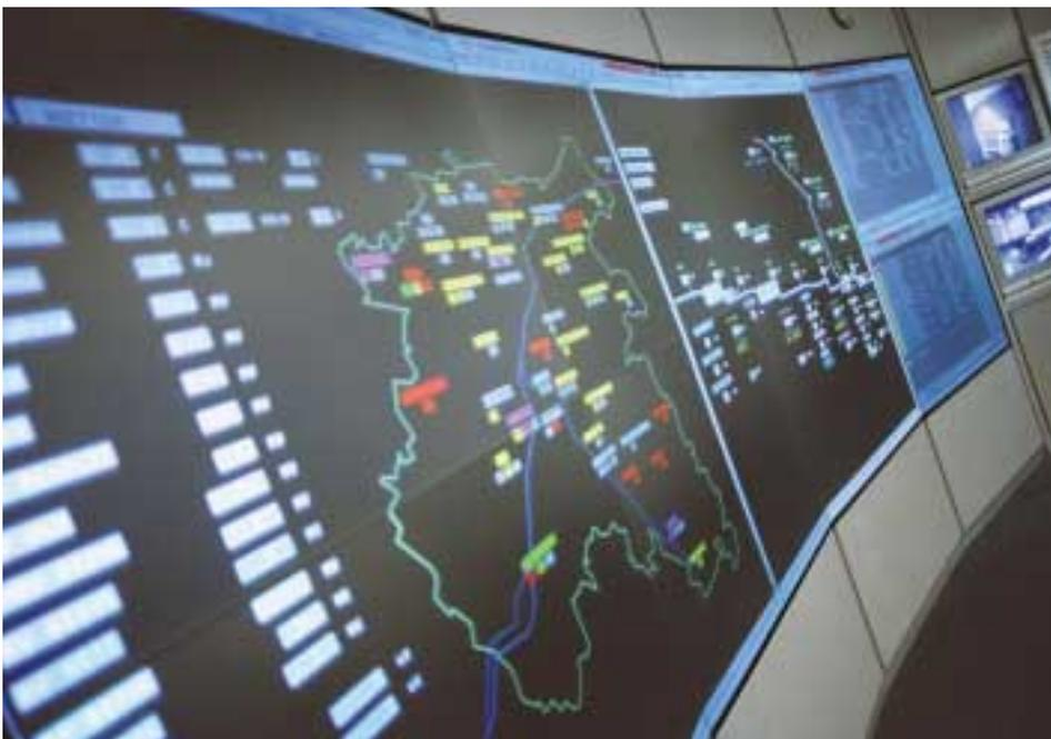
können, haben die Mitarbeiter zum einen die Möglichkeit, die eigenen Kraftwerke anzusteuern und auf diese Weise Einfluss auf die produzierte Strommenge zu nehmen. Zum anderen können sie Energie aus externen Quellen beziehen. Die bereitgestellte Energiemenge aus der Eigen- und Fremdproduktion wird von den Technikern zudem fortwährend bilanziert, um so die Berechnung der Netznutzung zu ermöglichen.
