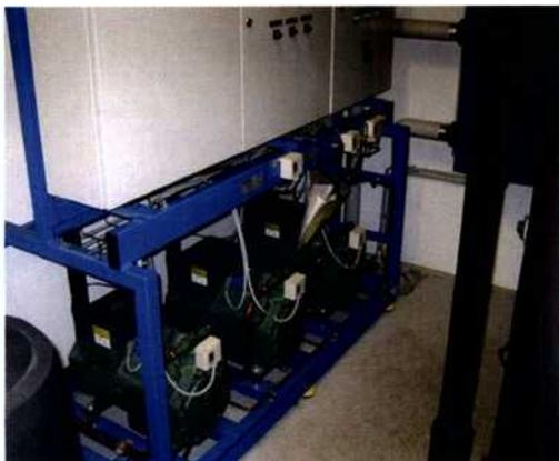
Hauser Kälteanlage im Feldtest mit den Kältemitteln CO<sub>2</sub> und R134a bzw. Opteon XP10.
