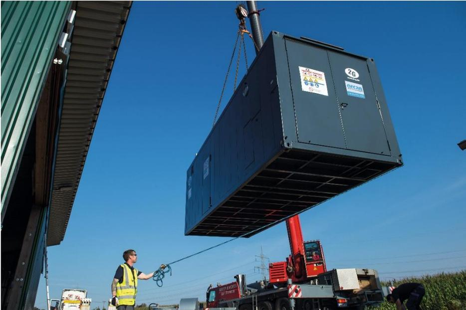
Bildlegende: Die Kombination aus 2G BHKW mit nachgeschaltetem ORC-Modul kann als kompakte Containerlösung in kürzester Zeit installiert werden.
