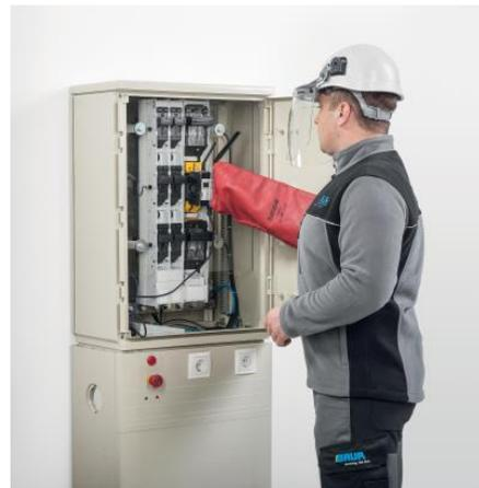
Im Sicherungsschrank eingebauter LV-Guard
